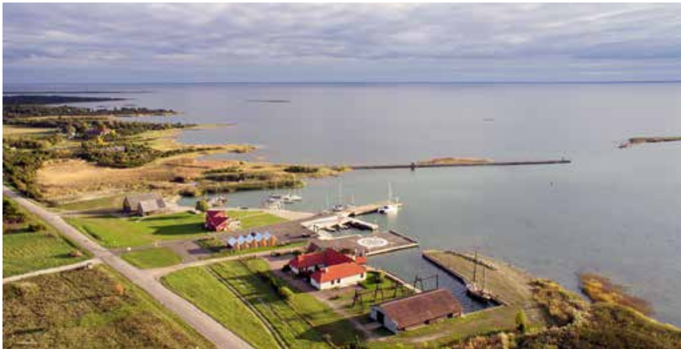
▲ Le port d'Orjaku a été complètement rénové...
