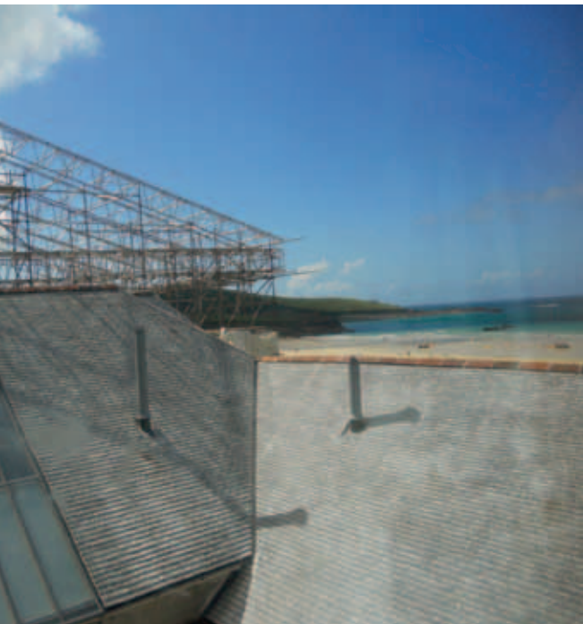
▲ Porthmeori Studio katuse renoveerimine.
