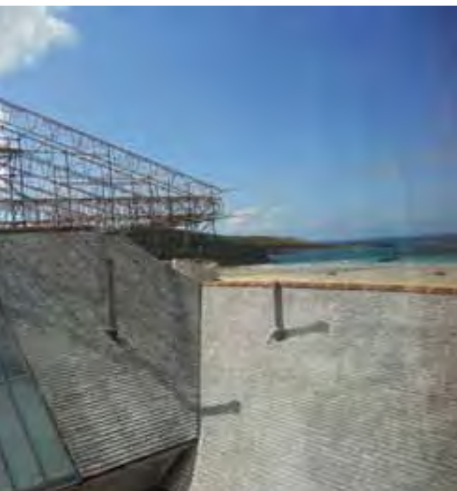
▲ Renovación del techo de los Estudios y sótano del Centro Porthmeor.
