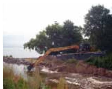
▲ Dragage d'un port à l'aide d'une excavatrice flottante.
