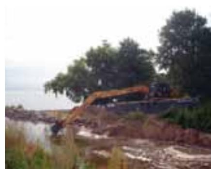
▲ Dragado de un puerto con una excavadora flotante.
