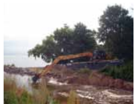
▲ Ein Schwimmbagger hebt den Hafen aus.
